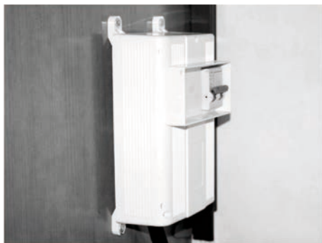
Bild 57: Huvudbrytare (jordfelsbrytare)
