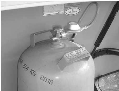
Bild 86: Gasolflaska med tryckreducerventil
