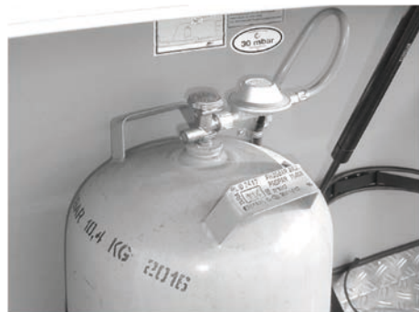
Bild 68: Gasolflaska med lågtrycksregulator och lågtrycksslang
