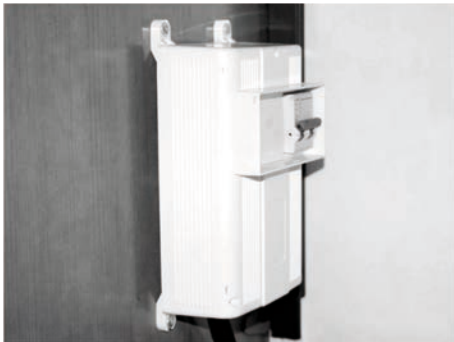
Kuva 3: Pääkytkin (FI-suojakytkin)
