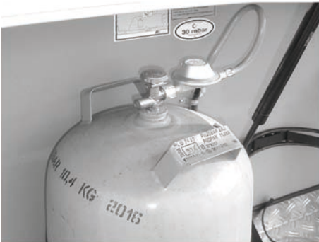
Kuva 73: kaasupullo, jossa matalapainesäädin ja matalapaineletku
