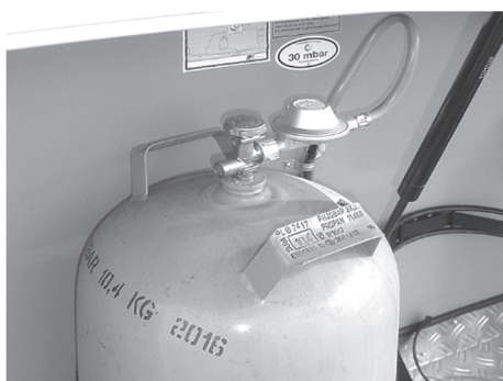
Bild 75: Tryckreducerventil
