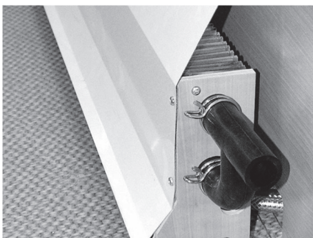
Bild 87: Konvektor med värmeledningsplåt
