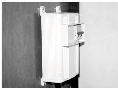
Kuva 57: Pääkytkin (FI-suojakytkin)
