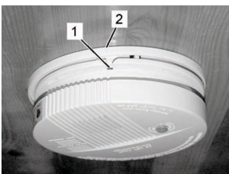
Kuva 229: Rungon kiinnitys paikoilleen
