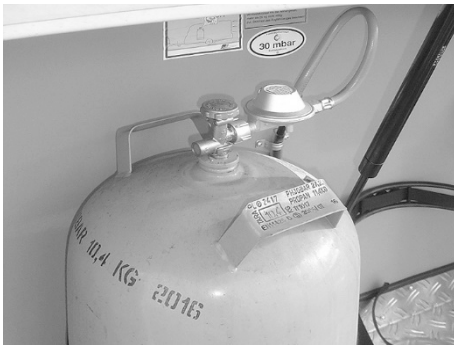
Kuva 108: Kaasupullo ja paineenalennusventtiili
