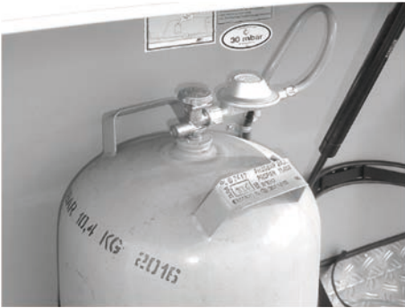
Kuva 70: kaasupullo, jossa matalapainesäädin ja matalapaineletku
