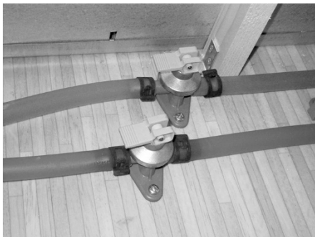
Afb. 160: Aftapkranen gesloten
