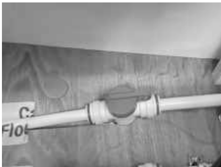
Afb. 91: Klep voor ALDE-vloertemperatuurregeling
