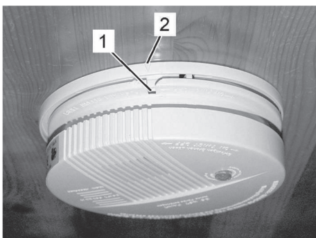
Abb. 207: Gehäuse ansetzen
