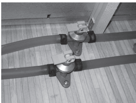
Abb. 151: Ablassventile geschlossen
