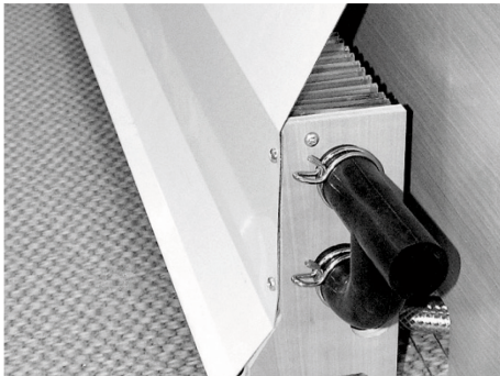
Abb. 83: Konvektor mit Wärmeleitblech
