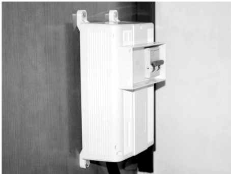
Abb. 59: Hauptschalter (FI-Schutzschalter)
