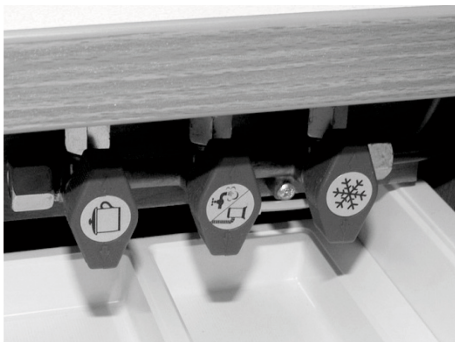
Abb. 69: Schnellschlussventile
