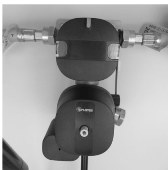
Abb. 105: Gasversorgung DuoControl CS
