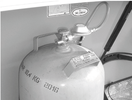
Kuva 71: kaasupullo, jossa matalapainesäädin ja matalapaineletku
