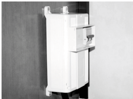
Kuva 59: Pääkytkin (FI-suojakytkin)
