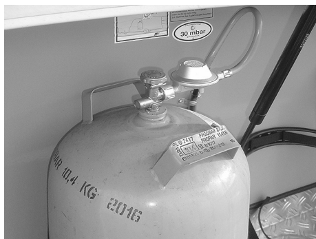
Fig. 104: Bombola di gas con valvola riduttrice di pressione
