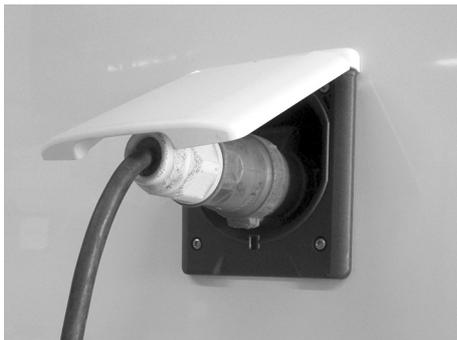
Abb. 2: Elektrischer Netzanschluss
