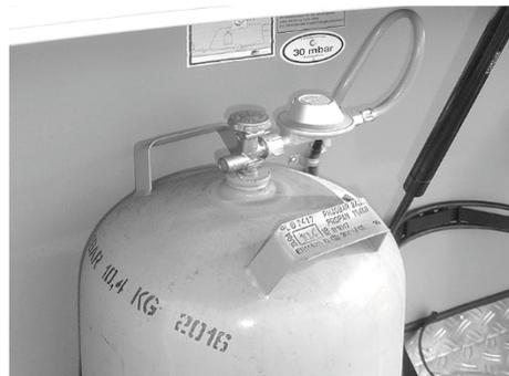
Abb. 64: Gasflasche mit Niederdruckregler und Niederdruckschlauch
