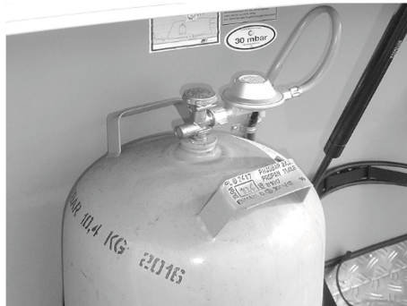
Kuva 64: kaasupullo, jossa matalapainesäädin ja matalapaineletku
