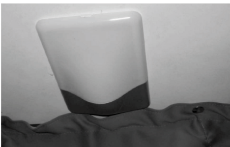
Kuva 144: Lampun suojuksen asentaminen
