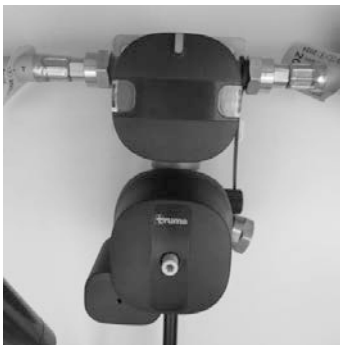
Fig. 109: Alimentazione del gas DuoControl CS
