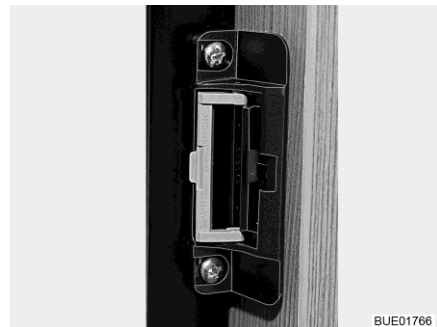
Bild 90 Verschlusseinrichtung in Lüftungsstellung
