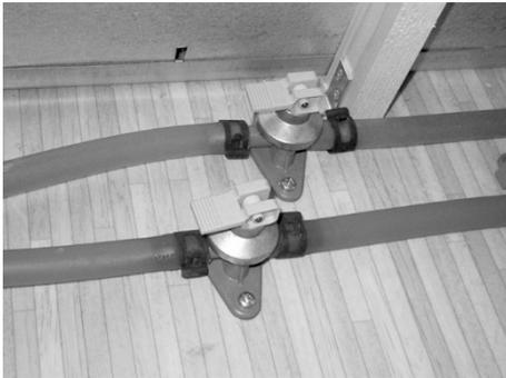
Abb. 168: Ablassventile geschlossen
