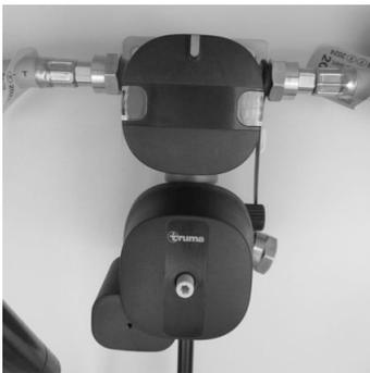
Abb. 115: Gasversorgung DuoControl CS
