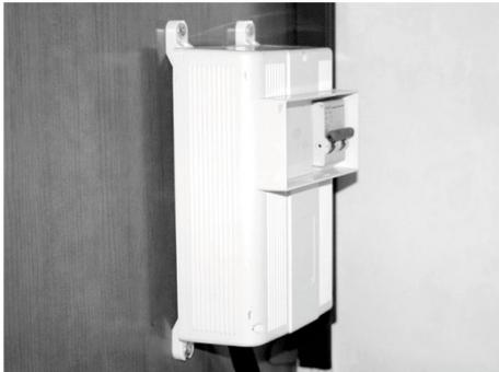
Abb. 66: Hauptschalter (FI-Schutzschalter)
