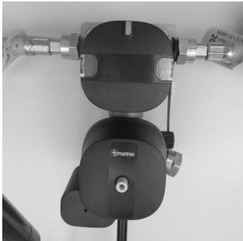
Abb. 82: Gasversorgung (mit Eis-Ex und Fernanzeige)
