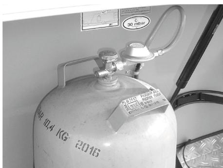
Abb. 81: Gasflasche mit Niederdruckregler und Niederdruckschlauch
