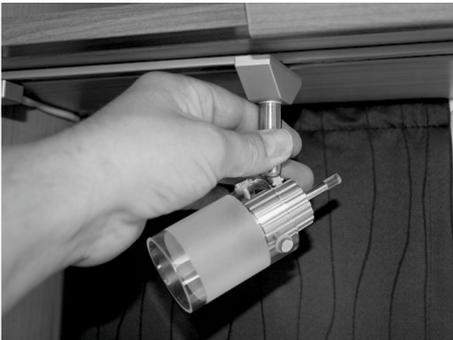
Abb. 69: LED-Strahler versetzen
