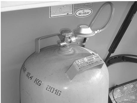
Abb. 114: Gasflasche mit Druckminderventil
