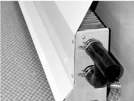
Abb. 93: Konvektor mit Wärmeleitblech
