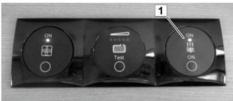
Abb. 100: Ein-/Aus-Schalter der Fußbodentemperierung
