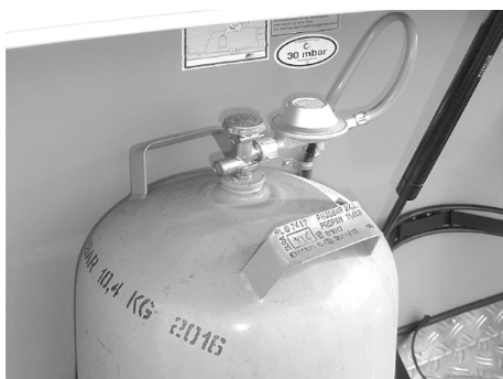
Fig. 81 : Bouteille de gaz avec détendeur basse pression et flexible basse pression
