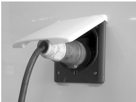
Afb. 2: Elektrische netaansluiting
