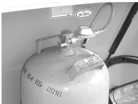
Afb. 81: Gasfles met lagedrukregelaar en lagedrukslang
