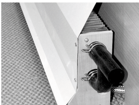
Afb. 93: Convector met warmtegeleidingplaat
