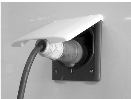
Afb. 55: Elektrische netaansluiting
