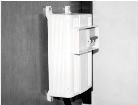
Fig. 3 : Interrupteur principal (disjoncteur différentiel)
