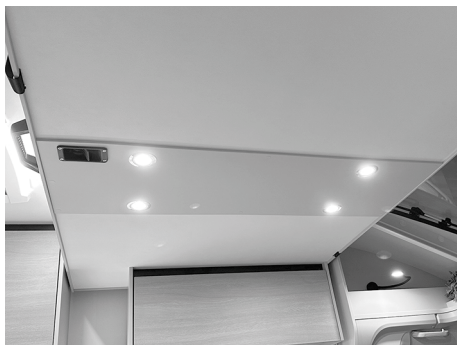
Fig. 58 : Spots à LED sous le lit relevable
