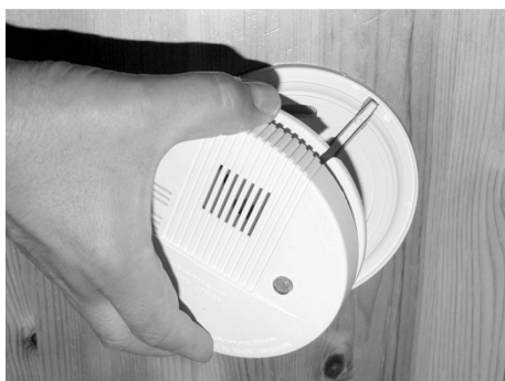
Fig. 160: Retirer le boîtier
