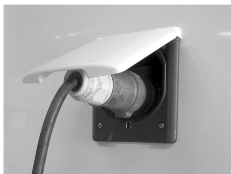
Fig. 55 : Branchement électrique sur le secteur
