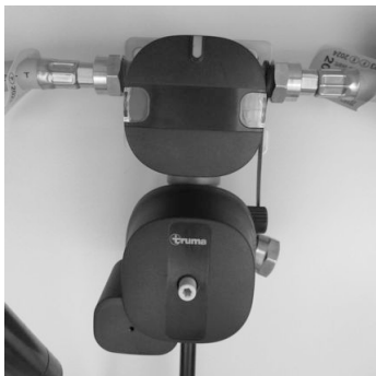
Kuva 89: Kaasusyöttö (Eis-Ex:llä ja kaukonäytöllä)
