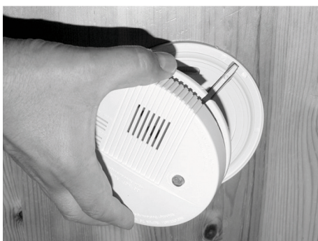
Kuva 119: Rungon irrotus
