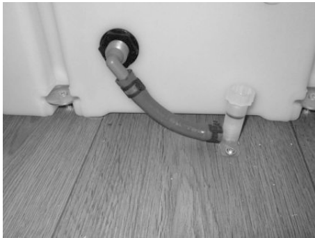
Abb. 95: Entleerungsventil, Beispiel
