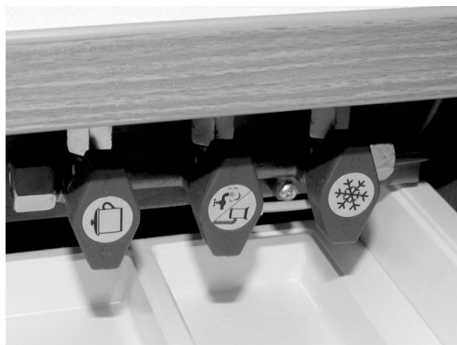
Abb. 80: Schnellschlussventile
