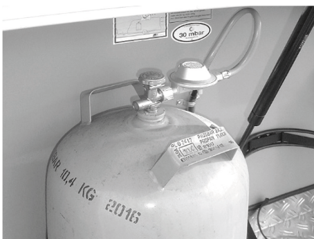
Abb. 77: Gasflasche mit Niederdruckregler und Niederdruckschlauch
