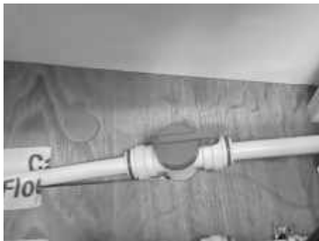
Abb. 91: Ventil Fußbodentemperierung ALDE
