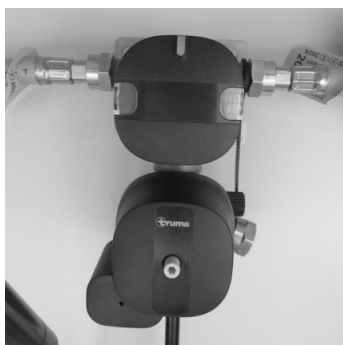
Fig. 114: Alimentazione del gas DuoControl CS
