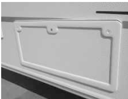
Abb. 14: Wohnaufbau, Servicefach außen
