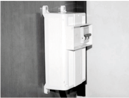
Abb. 3: Hauptschalter (FI-Schutzschalter)
