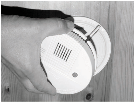
Abb. 142: Gehäuse abnehmen
