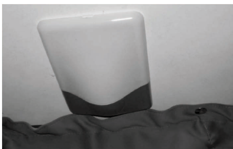
Abb. 135: Lampenabdeckung montieren
