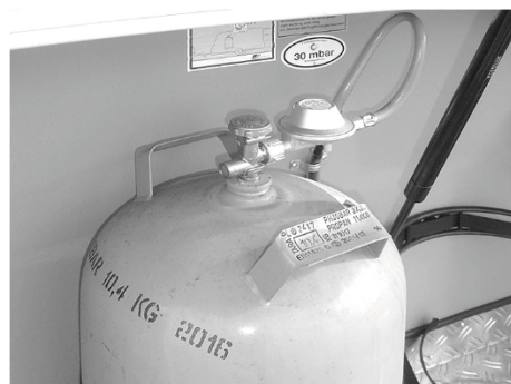
Afb. 63: Gasfles met lagedrukregelaar en lagedrukslang
