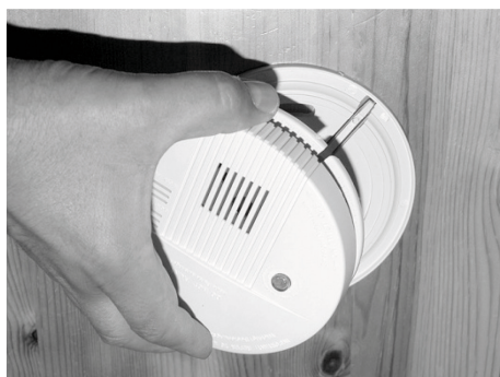
Fig. 142: Retirer le boîtier
