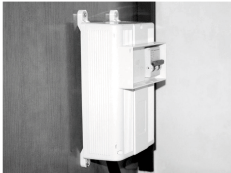
Abb. 3: Hauptschalter (FI-Schutzschalter)
