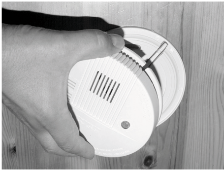
Abb. 169: Gehäuse abnehmen
