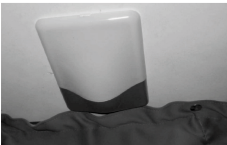
Abb. 162: Lampenabdeckung montieren
