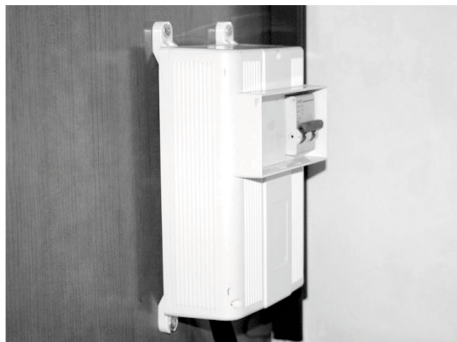
Fig. 3 : Interrupteur principal (disjoncteur différentiel)
