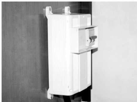
Fig. 59 : Interrupteur principal (disjoncteur différentiel)
