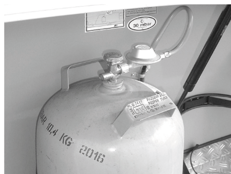
Fig. 74 : Bouteille de gaz avec détendeur basse pression et flexible basse pression
