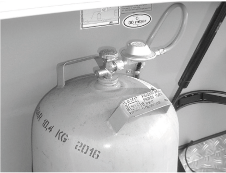
Abb. 70: Gasflasche mit Niederdruckregler und Niederdruckschlauch
