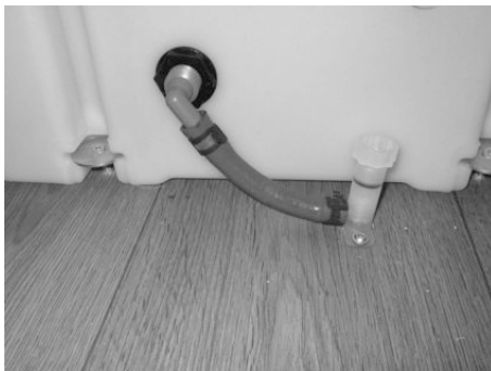
Abb. 99: Entleerungsventil, Beispiel
