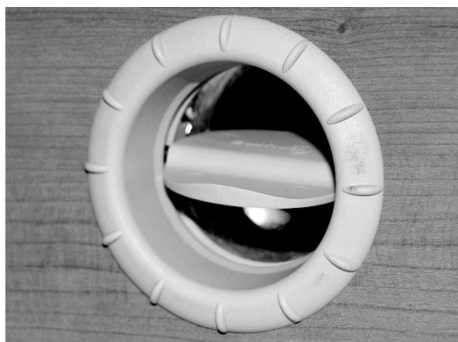
Fig. 129: Buse d'air chaud, ouverte
