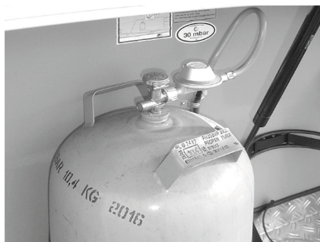
Fig. 70 : Bouteille de gaz avec détendeur basse pression et flexible basse pression
