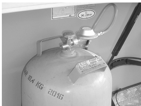
Fig. 108 : Bouteille de gaz avec détendeur
