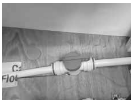
Fig. 86 : Vanne du chauffage au sol ALDE
