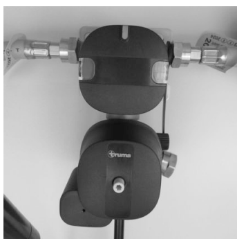
Fig. 114 : Alimentation en gaz DuoControl CS
