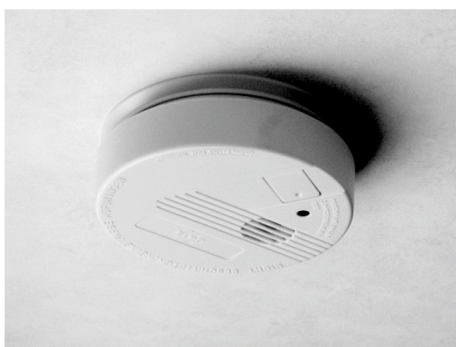
Fig. 59: Détecteur de fumée
