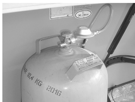
Fig. 112 : Bouteille de gaz avec détendeur
